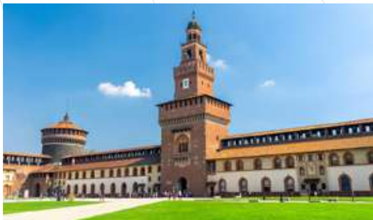
03. Castello Sforzesco, Milano Rivellino di Santo Spirito
